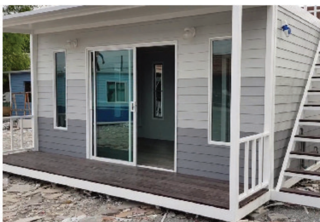
บ้านประกอบเสร็จ
