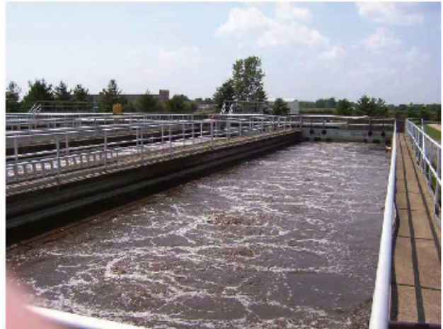
บ่อบำบัดน้ำเสีย
