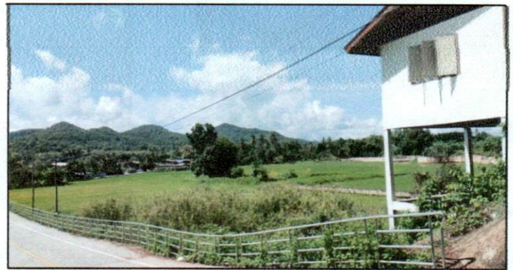
(ก่อสร้างลำเหมืองไหล่ทางคอนกรีตเสริมเหล็กบ้านบุง)
